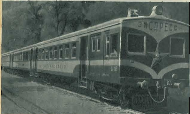
● Un diretto sulla linea elettrificata Tbilisi-Borgiomi (Transcaucasia), che funziona a 3000 V continui.
