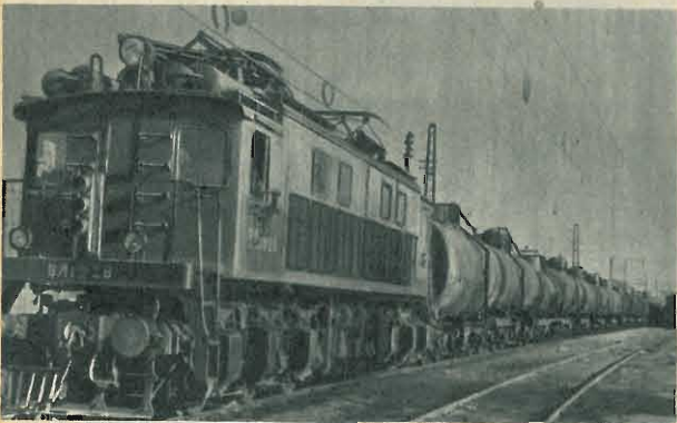
● Locomotore elettrico C-G, tipo V.L. (Vladimiro Lenin): 2800 cav. peso totale 114 t, lunghezza 16,02 m.
